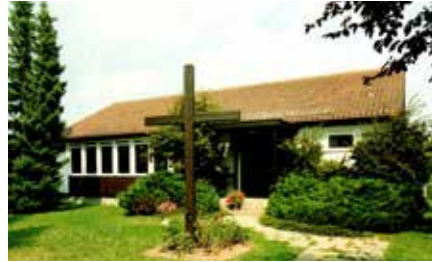
Der Vorgängerbau unseres heutigen Kirchen-Gemeinde-Zentrums
